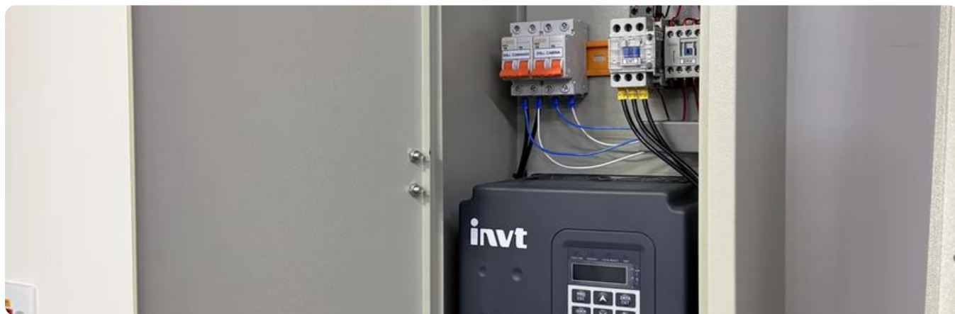
Quadro de comando PFX com inversor de frequência, montado na fábrica.
